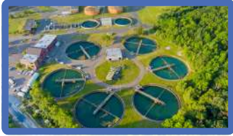
MONITOREO Y TRATAMIENTO DEL AGUA
